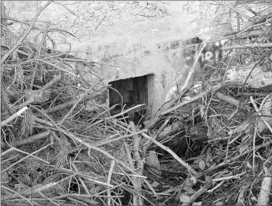
Vermauerter Stolleneingang im Jonastal.
