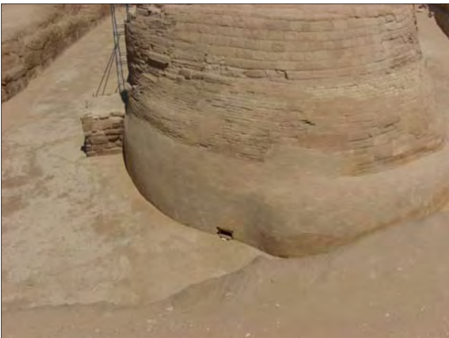
Das Hinterteil des Sphinx. Man sieht, dass er im Laufe der Zeit fast bis zum Rücken ausgebessert wurde. Die kleine Öffnung (siehe auch die Ausschnittsvergrößerung) am Schwanzansatz führt zu einem Schacht, der nach wenigen Metern verschüttet ist.
