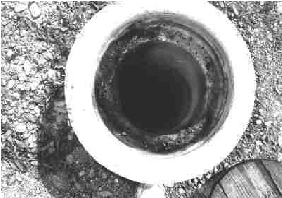
Abb. 7: Blick in das nordöstliche Rohr: es ist trocken, weil die Blind Spring verfehlt wurde.
