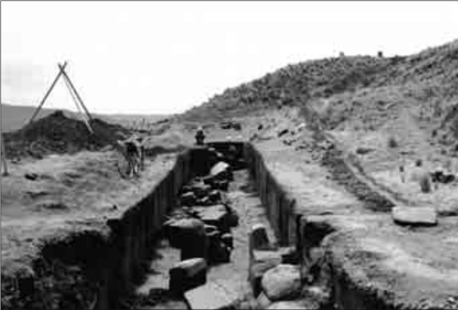
Abb. 10: Nordseite, Acapana. Hier sieht man sehr schön, wie schon zu früher Zeit die geometrisch perfekt behauenen Steine in eine wesentlich primitiver ausgeführte Mauer hineingebaut wurden.
