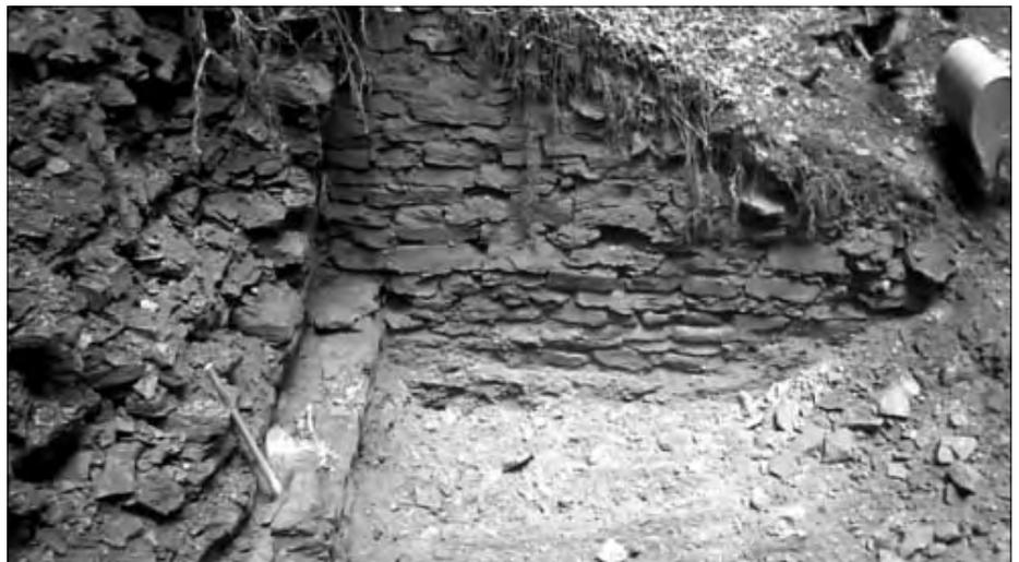
Abb. 4: Mauerwerk mit Grund- und Stützmauern.
