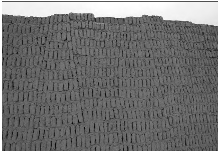
Bild 2: Erdbebensichere Bauweise mit Lehmziegeln in Trapezform (sowohl in der direkten Ziegelanordnung als auch in der übergeordneten Mauerstruktur).
