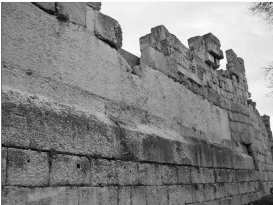
Abb. 15: Zwei der sogenannten Trilithon-Steine, deren Gewicht auf ca. 700 bis 800 Tonnen geschätzt wird. Auf diesem künstlichen Massiv wurde – später – der Jupiter-Tempel errichtet.
