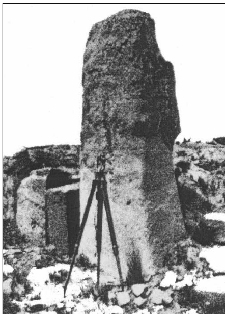
Abb. 11: Hier noch einmal einer der stark erodierten Andesit-Pfeilerblöcke aus der Ostmauer. Es mutet eher wie weicher Sandstein an.
