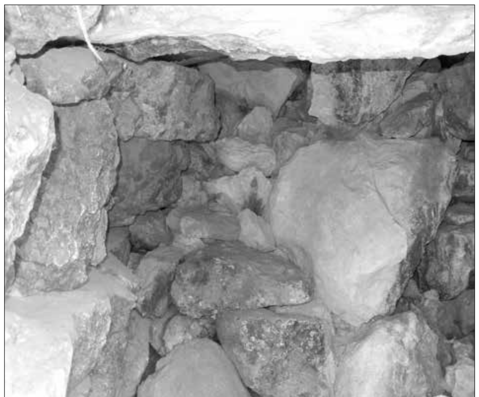
Das unspektakuläre Innere des Hohlraums.
