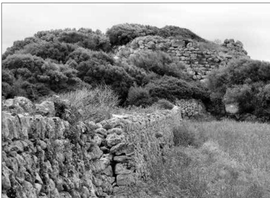
Bild 2: Turmreste und Mauern (Torre Llafuda)
