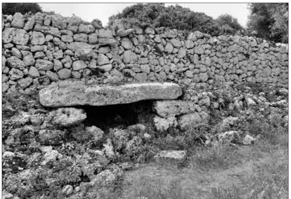
Bild 7: Tor in der Wehrmauer von Torre Llafuda.
