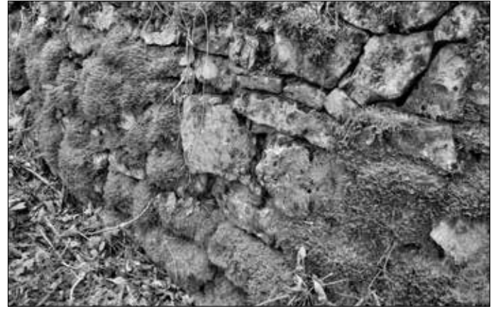
Bild 26 (links): Sorgfältig geschichtete Trockenmauer. Bild 27 (rechts): Trockenmauer mit behauenen Steinen.
