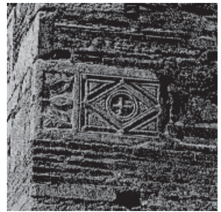
Typisches Beispiel der Mauerverfugung von Eptapyrgion (Thessaloniki)
