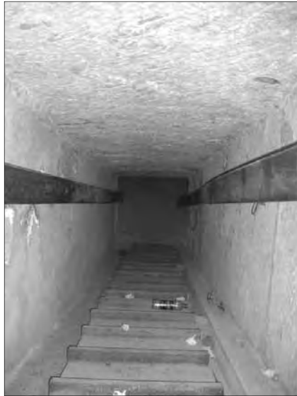
Die Bearbeitungsspuren im Abwärtsgang in der Chephren-Pyramide zeigen, dass er nur grob in den Felsboden gehauen und die Wände nur unzureichend geglättet wurden.
