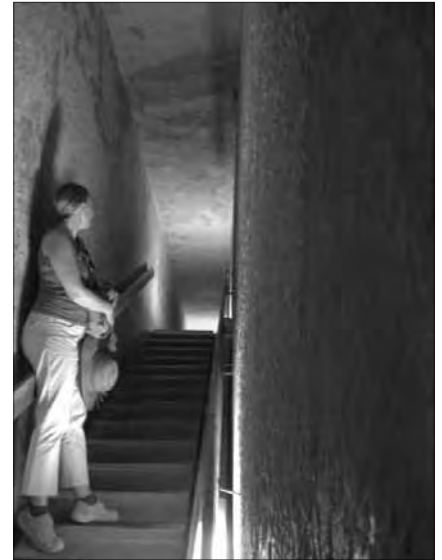
Auch der Aufstieg zur „Königskammer“ ist nur grob in den Felsen gehauen worden. Oben links an der Wand erkennt man eine nachträglich verputzte Stelle.
