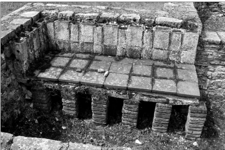
Abb. 4: Römische Fußbodenheizung
