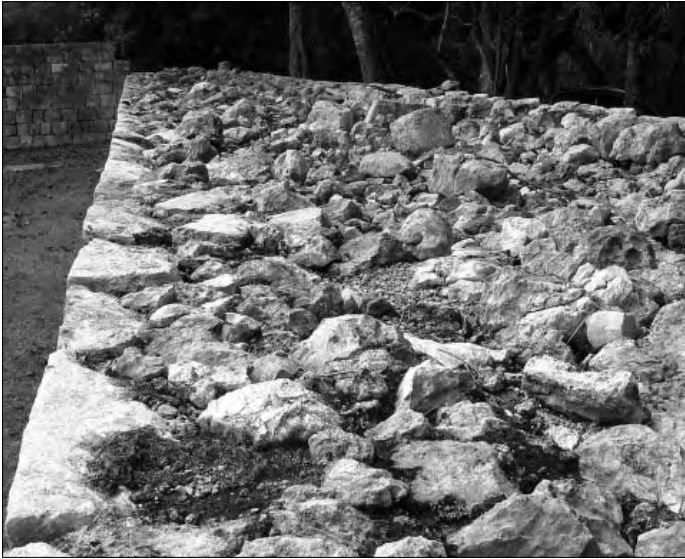
Bild 4 (links): Uxmal, Mauer mit bearbeiteten Seiten und innen Bruchstein. Bild 5 (rechts): Uxmal, Pyramide außen bearbeitet, innen Bruchstein
