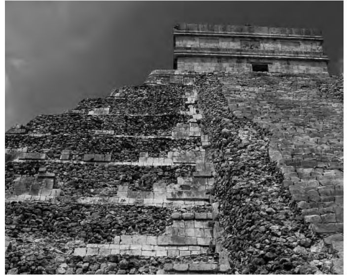
Bild 4 (links): Uxmal, Mauer mit bearbeiteten Seiten und innen Bruchstein. Bild 5 (rechts): Uxmal, Pyramide außen bearbeitet, innen Bruchstein
