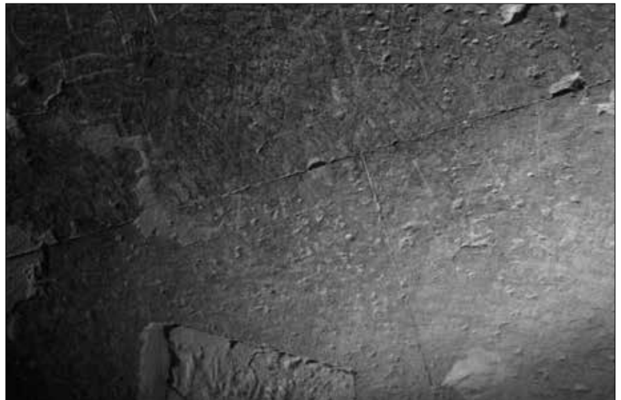
Auch die sauber verarbeiteten Granitblöcke in der „Großen Galerie“ wurden passgenau ohne Mörtel verlegt.
