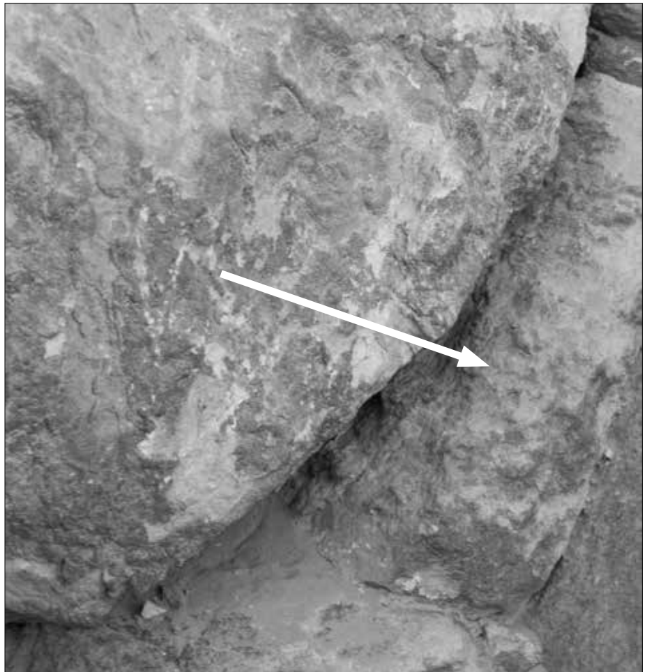
Ein weiterer breiter Spalt an der Mykerinos-Pyramide, der mit Mörtel verfüllt wurde. (Hier: Ostseite)
